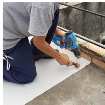
Nos cantos ou em partes irregulares da superfície, um soprador térmico ajuda a moldar e a acomodar a manta ELamix sem complicações.
