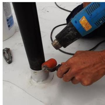
Para um melhor acabamento e proteção hídrica, os recortes são cobertos com pedaços da manta Elamix em formatos específicos.
