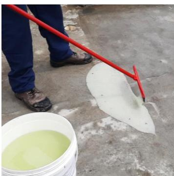
A aplicação do primer (adesivo) é feito através de um simples rodo que espalha o primer, cobrindo toda a superfície onde será colocada a manta Elamix.
